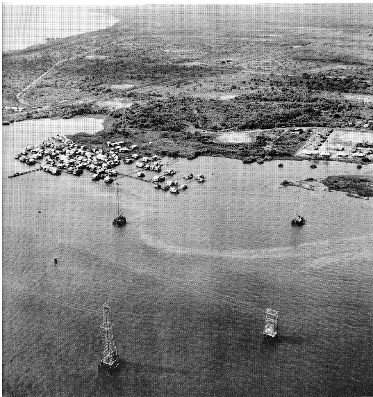
Planche I - Pueblo Viejo sur les bords du lac de Maracaïbo (1956). Vieux village de pêcheurs construit sur pilotis et camp moderne de la Shell.
