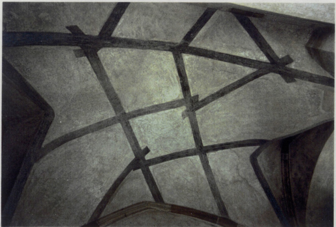
Voûtes des salles de l'aile Louis II de château de Prague avec et sans nervures
