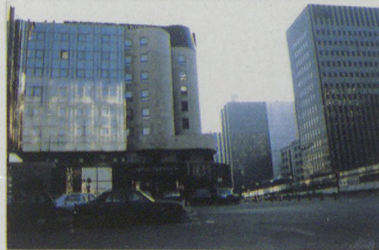
Vue depuis le Parvis DIDEROT
