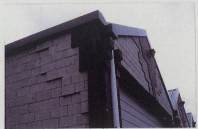
Détail d'appareillage d'angle Voir plan de calepinage
