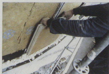
Mise en œuvre de la pierre dans le cas du mur courbe
