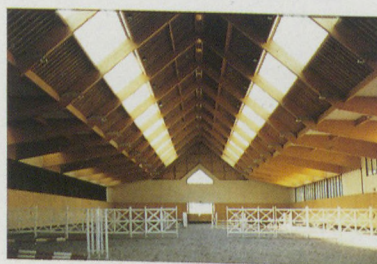
Vue intérieure du manège
