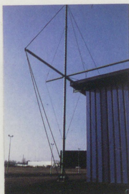
Hauteur du mât : 28,00 m
