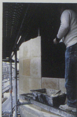
Mise en œuvre de la pierre dans le cas du mur courbe
