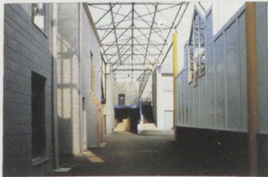
Vue de la rue couverte depuis l'entrée principale
