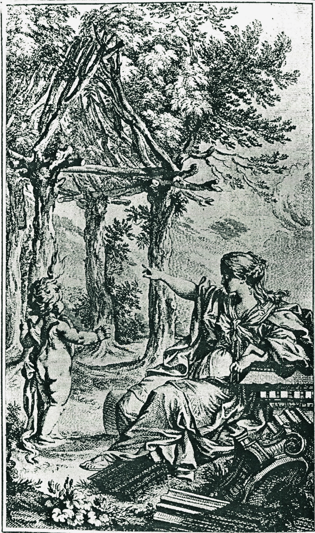
M.-A. Laugier, Essai sur l'architecture (1753), frontispice montrant la cabane primitive origine de l'architecture et modèle d'un art rationnel selon l'auteur. La cabane primitive de Laugier constitue un parfait exemple de lisibilité spatiale et constructive. Elle permet de faire coïncider l'analyse des notions fondatrices de la discipline architecturale avec celle des parties d'ouvrage et de leurs fonctions.
