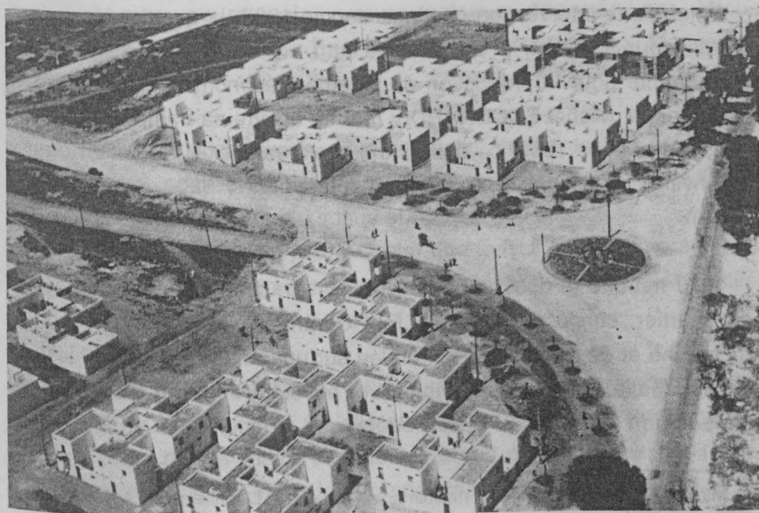
PL.5 En haut, l'habitat horizontal de Michel ECOCHARD et l'habitat marocain vertical de Georges CANDILIS (photo Michel ECOCHARD); en bas l'opération Hay Hassani de Elie AZAGURY. (Photos aériennes Verbelke)
