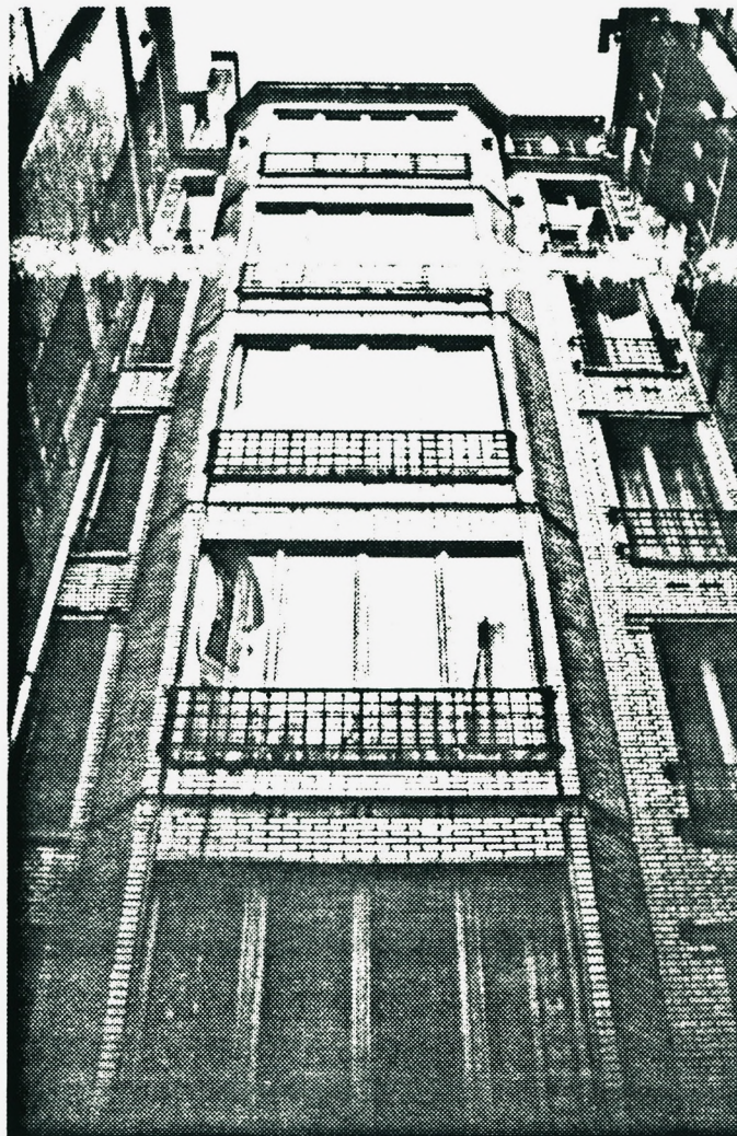
Fenêtres de salles à manger sur la cour .
