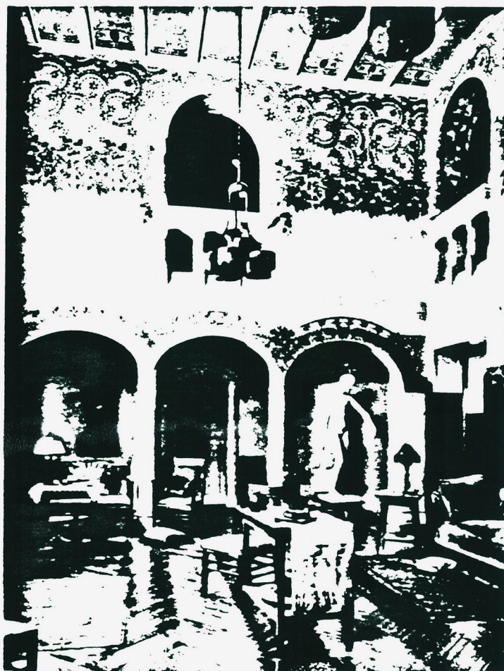
Hall , côté arcades, rue de Villejust, Ch. Plumet
