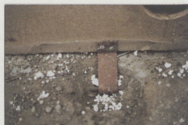
Détail de l'ancrage avant le scellement
