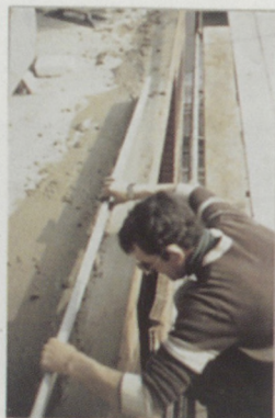
Lissage de l'arase, enlèvement de la protection de la semelle de mousse adhésive de la bavette, puis pose de la bavette
