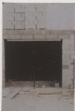
Stockage direct sur la dalle
