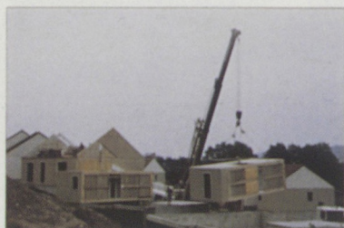
Levage du module au camion-grue
