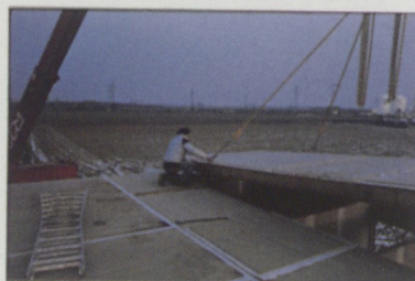
Pose d'un panneau de plancher préfa
