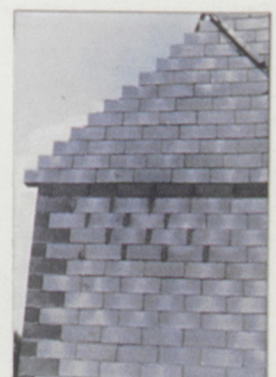
Bon calepinage du pignon
