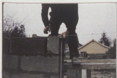
Mise à l'aplomb du 1/2 bloc tableau
