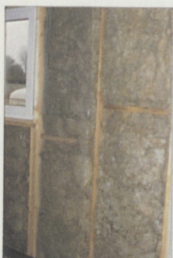
Isolation et réseaux posés
