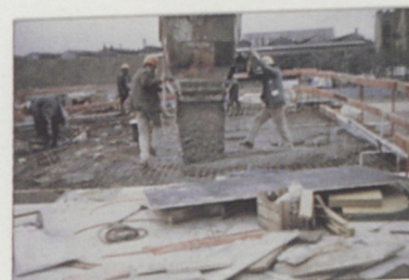
Équipement puis coulage de la dalle
