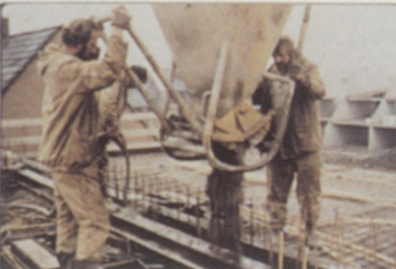
Coulage en commençant par les voiles
