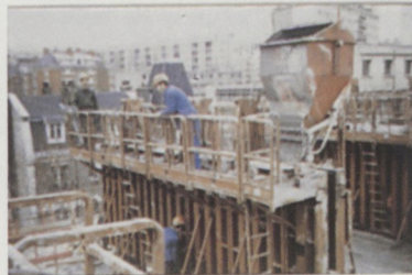
Resserrement des banches puis coulage
