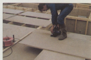
Ajustement d'un panneau à la scie
