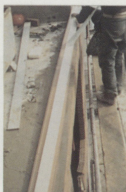
Lissage de l'arase, enlèvement de la protection de la semelle de mousse adhésive de la bavette, puis pose de la bavette
