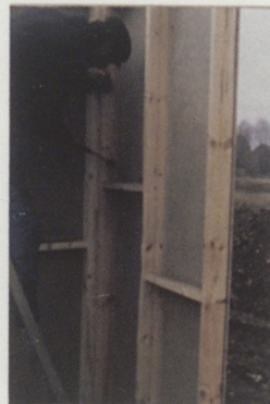
Assemblage par clouage
