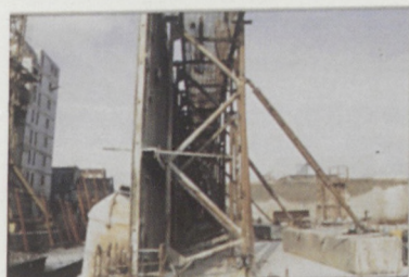
Stabilisation des banches par étais lestés
