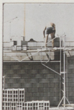
Échafaudage neuf et stable
