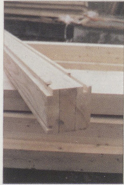
Détail d'un poteau d'angle
