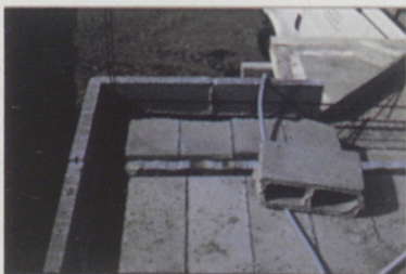
Planelles en béton en rive de plancher
