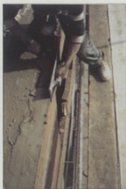
Lissage de l'arase, enlèvement de la protection de la semelle de mousse adhésive de la bavette, puis pose de la bavette
