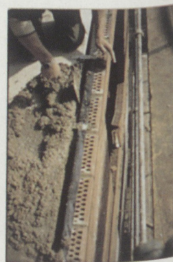
Pose du « bitu-thène » et des pattes inox, puis remplissage au mortier de liège-isolant
