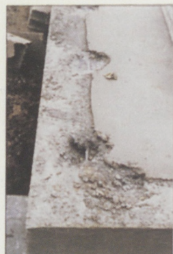
Fer d'ancrage du panneau
