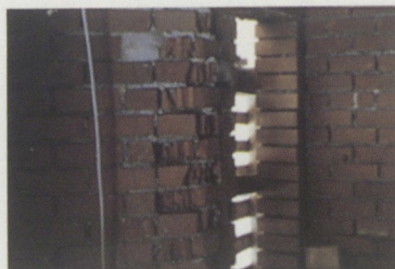
L'angle biais brut de gros oeuvre
