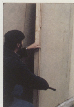
Mise en place de la languette
