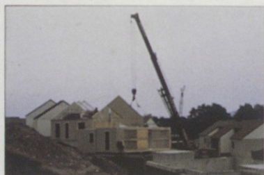
Pose du module sur le soubassement
