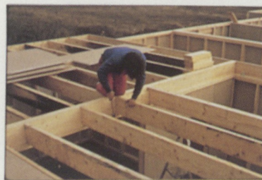
Pose et fixation des solives du plancher
