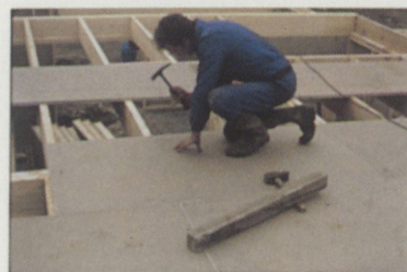
Clouage des panneaux sur les solives
