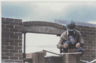
Traçage de la découpe sur la brique
