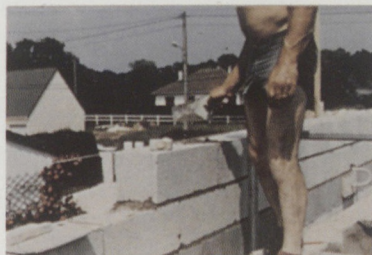
Réalisation du joint vertical au mortier
