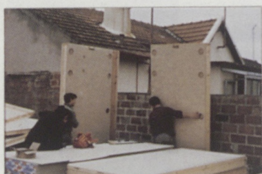
Assemblage en partant d'un angle
