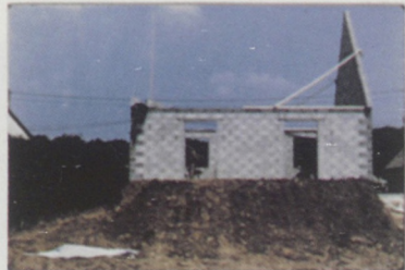
Exemple de gros oeuvre bien calepiné
