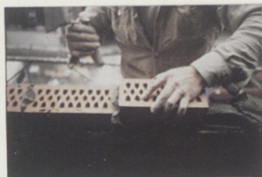
Joint refoulé en appuyant en poussant
