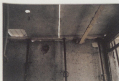
Bastings étayés soutenant les prédalles
