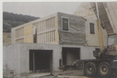
Le module posé, en attente du suivant
