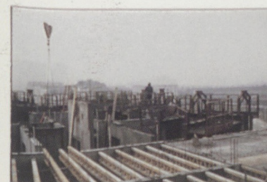
Pose des panneaux sur les poutrelles
