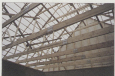
La charpente posée et contreventée
