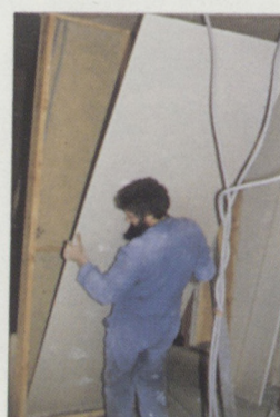
Pose des plaques de plâtre
