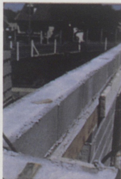
Blocs en U en couronnement
