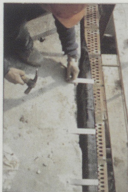
Pose du « bitu-thène » et des pattes inox, puis remplissage au mortier de liège-isolant
