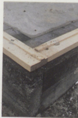
Détail de la lisse basse posée
