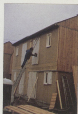
Bardage bois posé en pignon
