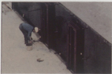
Pose d'un tunnel sur deux: équipement
