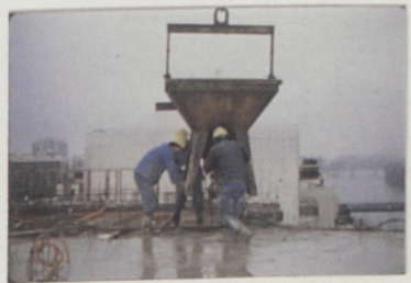
Fin du coulage, lissage à l'avancement
