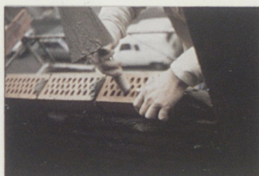
Frappe pour mise à niveau de la brique
