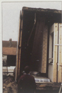
Déchargement du camion
