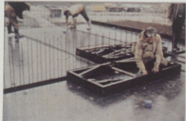
Réservation d'une trémie d'escalier
