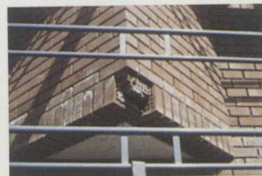
La pointe avant habillage en plaquette
