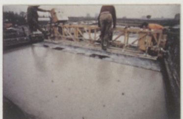
Lissage de la dalle à la règle vibrante
