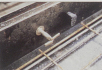
Intégration de douilles en rives de dalle
