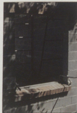
Appui de fenêtre en brique
