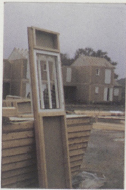
Panneaux stockés sur la dalle
