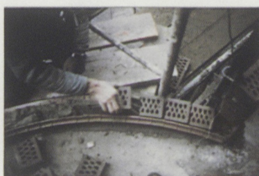
Pose du premier rang-ici sur une bavette
