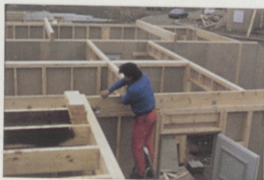
Mise en place et fixation des poutres
