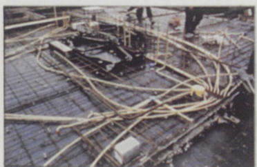
Pose des derniers tunnels, la dalle prête
