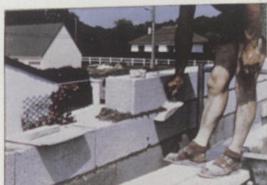
Enlèvement des balèvres de mortier
