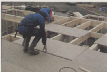
Emboîtement des panneaux à languette
