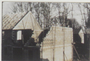
Réalisation des pointes de pignon
