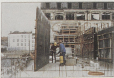
Fermeture du coffrage avant coulage
