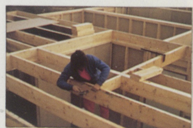
Pose des entretoises entre les solives
