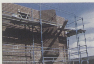
Vue de l'échafaudage placé à l'extérieur
