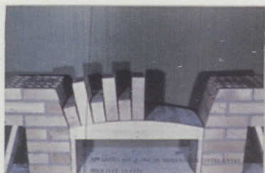
Appareillage à sec sur un cintre en bois
