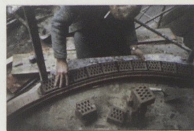
Réglage de la courbe avec un gabarit
