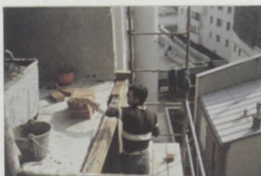
Maçonnage du « murfor » dans le joint
