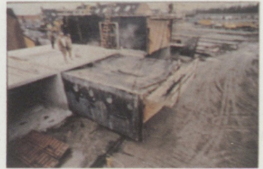
Décoffrage du tunnel par la façade
