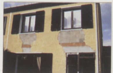
Résultat d'une maçonnerie hétérogène
