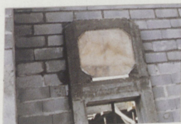
Ouvrage critique : encadrement en béton
