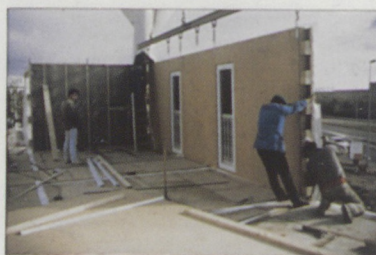
Pose d'un grand panneau de façade
