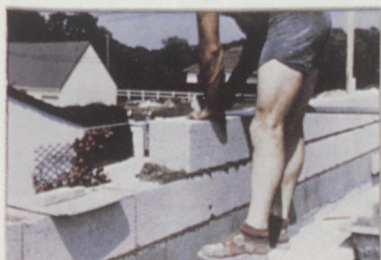
Pose du bloc, mise à niveau au maillet
