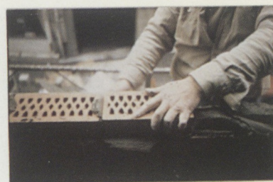
Enlèvement des balèvres de mortier
