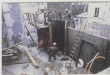
Pose des deux banches reliées en vis à vis
