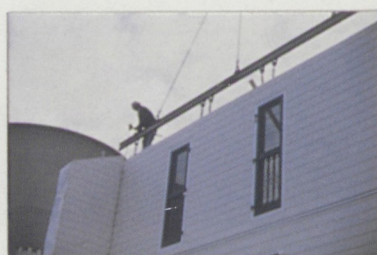
Vue des raccords en façade
