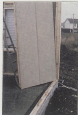
Pose du panneau à l'angle
