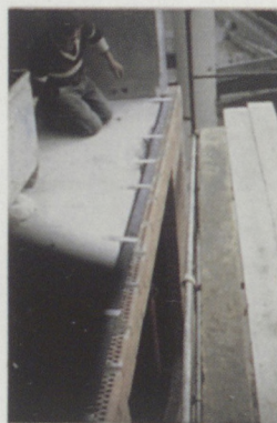
Pose du « bitu-thène » et des pattes inox, puis remplissage au mortier de liège-isolant
