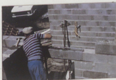
Coulage du linteau dans les blocs en U
