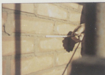
Lissage des joints à la truelle à joint
