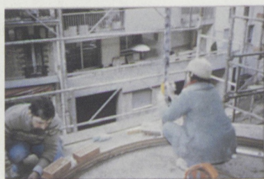
Calepinage des assises du mur courbe
