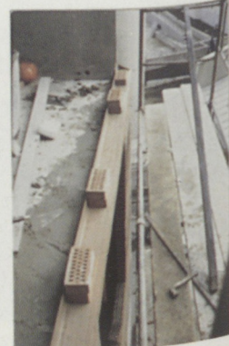
Lissage de l'arase, enlèvement de la protection de la semelle de mousse adhésive de la bavette, puis pose de la bavette
