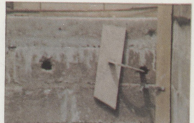
Ouvrage critique: arase en béton coffré
