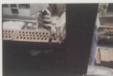
Pose de la demie brique du tableau
