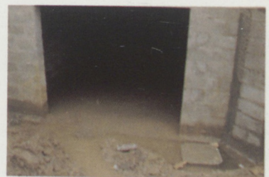
Ouvrage critique: angle biais - en béton
