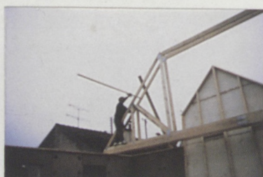
Pose des fermettes de la charpente
