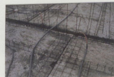
Ferrailage et équipement de la dalle
