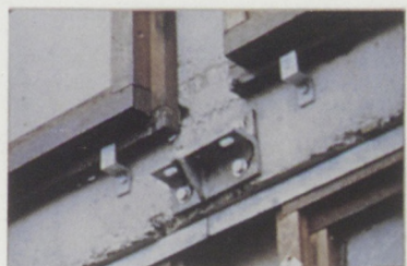
Fixation rapide et précise après coulage
