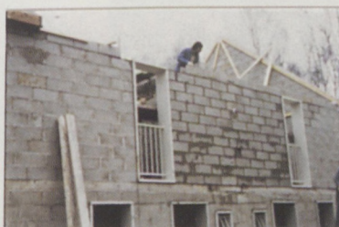
Ouvertures avec précadres métalliques
