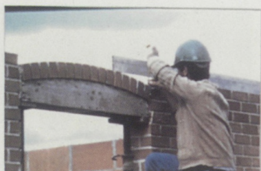
Mesure des dimensions à rattraper
