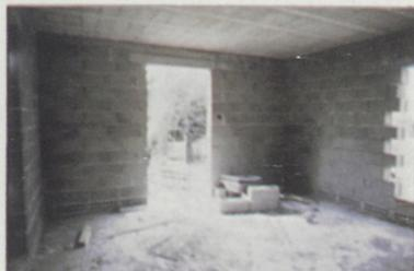
Mauvais calepinage vertical des murs
