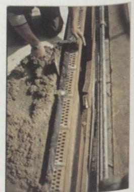
Pose du « bitu-thène » et des pattes inox, puis remplissage au mortier de liège-isolant
