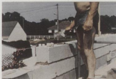
Réalisation du joint vertical au mortier
