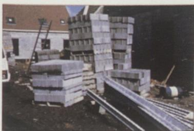
Mauvais stockage des matériaux au sol
