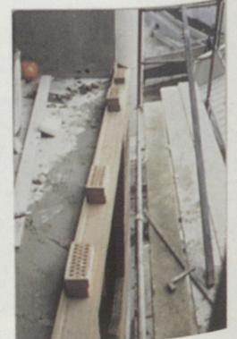
Lissage de l'arase, enlèvement de la protection de la semelle de mousse adhésive de la bavette, puis pose de la bavette
