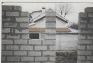
Mauvais calepinage des ouvertures
