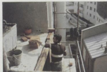
Maçonnage du « murfor » dans le joint
