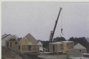
Levage du module au camion-grue
