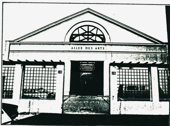
façade côté gare d'Austerlitz
