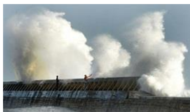
Figure 4 : Franchissement (© F. Tanneau)
