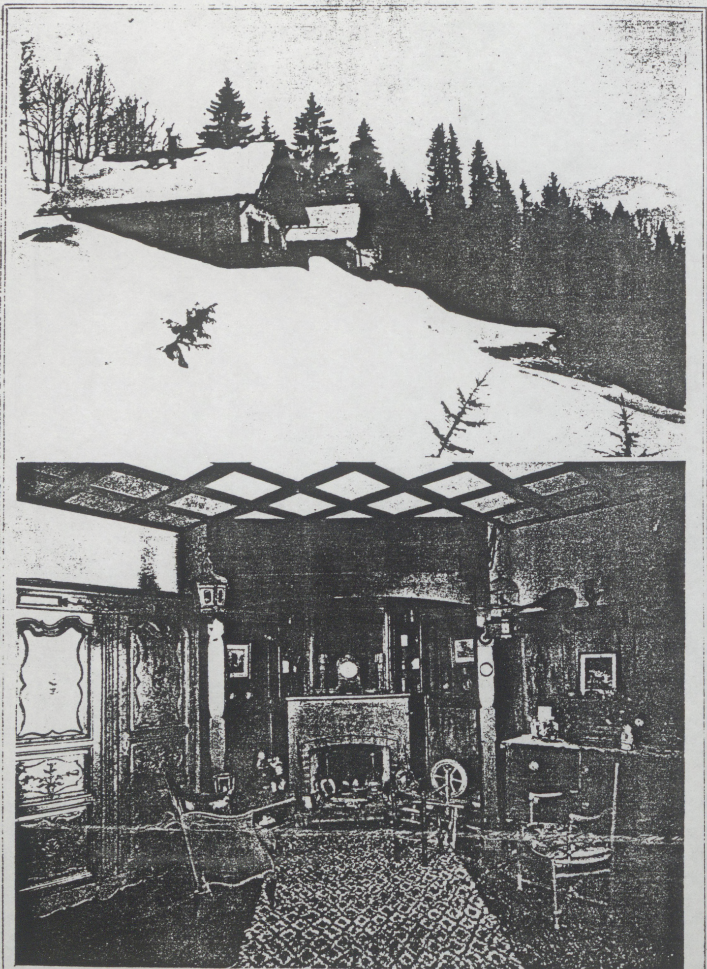
LES DEUX CHALETS « AU COIN DU FEU » ET « L'ABRI », dans leur cadre d'Hiver, se détachent en vigueur sur le rideau des grands sapins. Ces deux Chalets, tous du Sud-Ouest, paraissent surgir de la neige, à laquelle succède bientôt toute la flore abondante et variée des prairies montagnardes. Le Salon du « Coin du Feu », dont les murs sont revêtus de boiseries sur une partie de leur hauteur, est aménagé pour comporter deux retraits pour se tenir, dans les deux angles diagonalement opposés, l'un étant occupé par le coin de feu. Des meubles rustiques et de style très simple, des objets usuels mis en œuvre décorativement complètent cet ensemble infiniment charmant.
