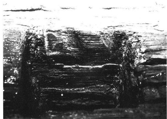
**Fig. 61** – Boisage des Fouilloux (Jumilhac-le-Grand, Dordogne) : traces de coups de ciseau à bois visibles sur le bord d'une mortaise.
