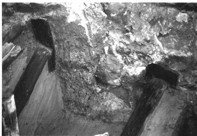
Fig. 62 – La Fagassière (Château-Chervix, Haute-Vienne) : étayage simple avec des planchettes utilisées pour caler des étais transversaux.
