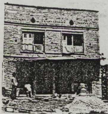
131. Maison n° 8 : façade principale.
