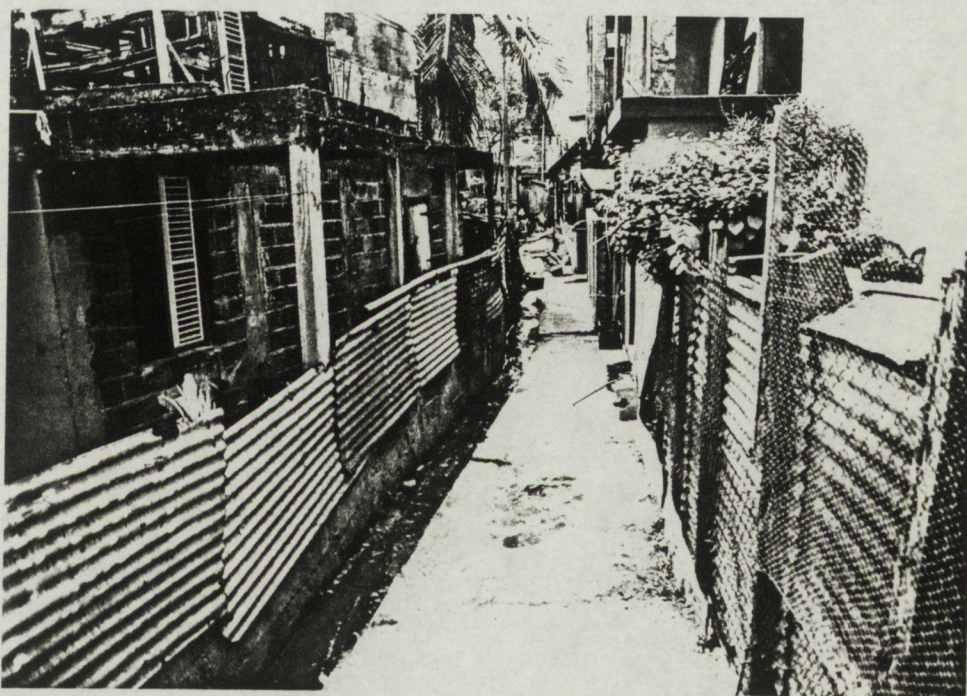
Rues secondaires à VOLGA PLAGE - Rue non assainie avec fossé latéral - Rue assainie avec dallage béton et caniveau canalisé
