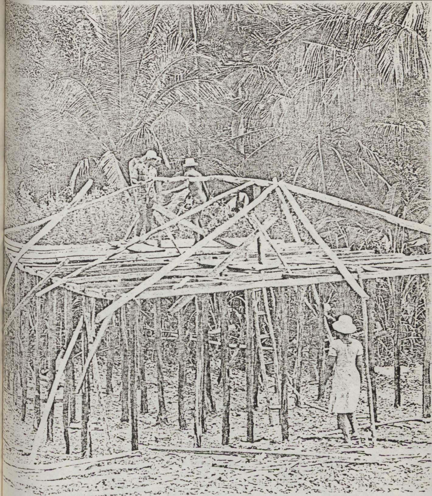
Le "koudmen" ou coup de main en milieu rural - élévation d'une charpente extrait de "KAZ ANTIYE JAN MOUN KA RETE, l'habitat populaire aux ANTILLES" par J. BERTHELOT et M. GAUME
