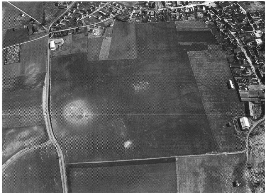
Fig. 6 – Vue aérienne de la partie basse du site : théâtre et thermes au milieu d'une vaste cour (photo R. Agache).
