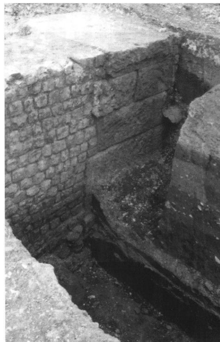
Fig. 49 – Pile de fondation dans le mur de soutènement du podium, côté nord (photo J.-L. Brunaux).
