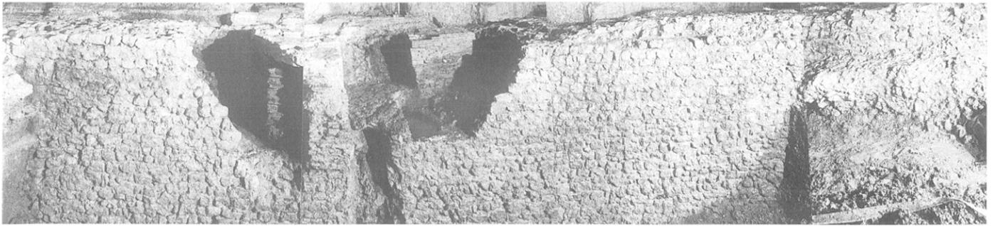
**Fig. 3.** *Vue générale (montage) des fondations en molasse de la façade sud du podium (photo J.-M. Martin).*
