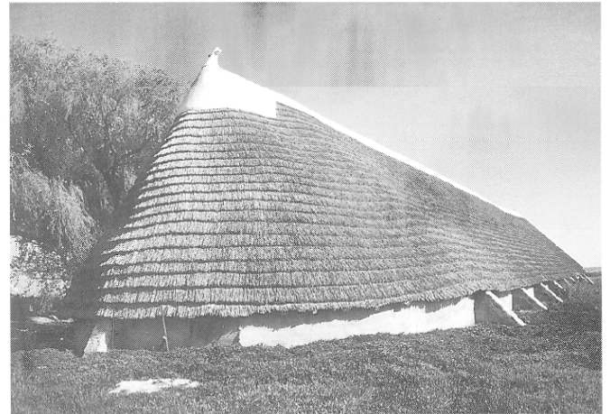
Fig. 23. Vue de l'abside de la bergerie moderne de la Favouillane.
