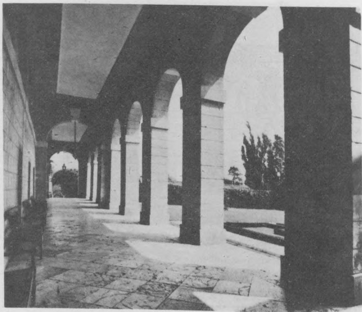
31. A. Palladio - Villa Barbaro à Maser galerie transversale
