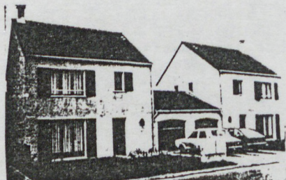
Fig.29. Le jumelage par les garages dans les lotissements modernes
