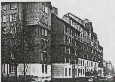
2 réalisations de l'OPHBM (PEULEVEY archi) ci-dessus 87, HBM, rue du Mail, Rouen 1930-31 Ci-contre 47 HBMA, rue Sénart, Rouen, 1933
