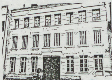
Fig.7. Maisons jumelées à porche central. Entrées privées sur rue, jointes au porche ou écartées (fig.154). Entrées privées sur porche
