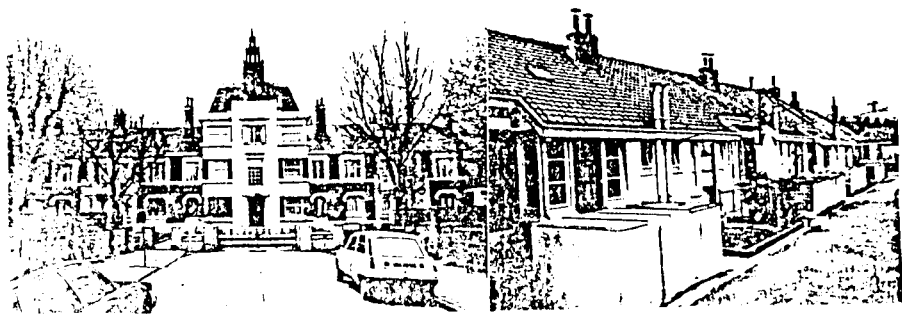
Fig.111. Groupe du faubourg d'Arras, Logements pour personnes âgées, O.P.M.B.M., 1934, J.SIXIERS architecte: 10 maisons individuelles et 18 Logements collectifs, d'après C.BRIANT, "Une Métropole social-démocrate, Lille, 1896-1919-1939, I.E.R.A.U., CORDA, 1977
