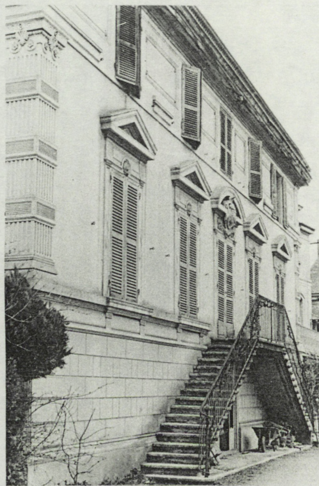
Fig. 85 La corniche de bois : premier indice d'une architecture d'enduit (Maison Relave - Ecully) .
