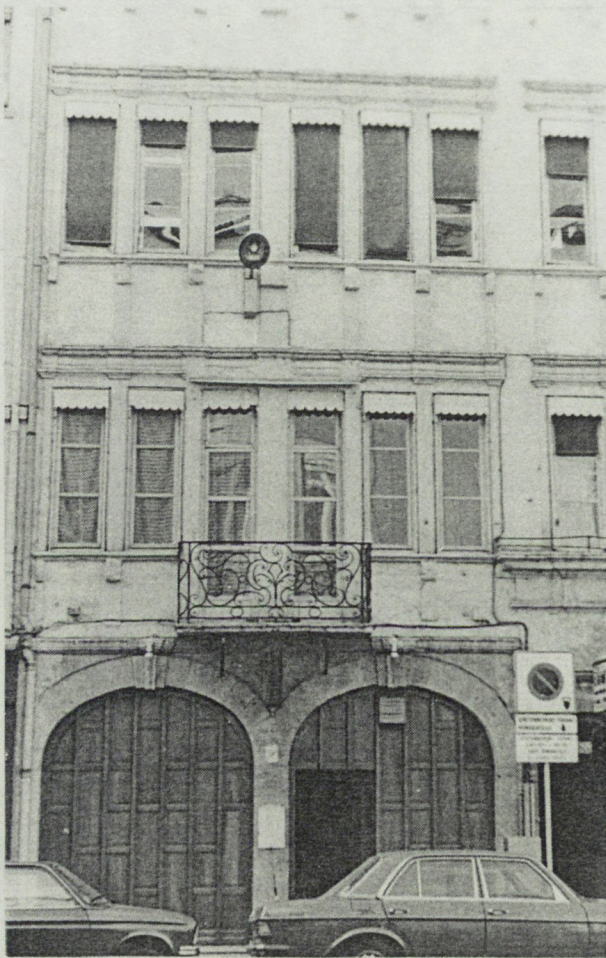
Fig. 43 Immeuble en pierres locales enduites : XVII e ème siècle (20, rue Bellecordière).
