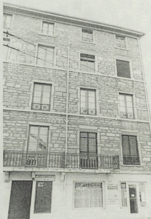
Fig. 34 Façade en moellons équarris assisés (Fin XIX e - 27, quai Jàyr)
