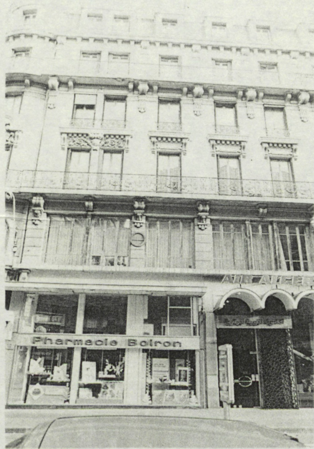
Fig. 59 Rez-de-chaussée et entresol commercial, 3 étages, un étage attique dans un immeuble fin XIXème (Rue E. Herriot) .
