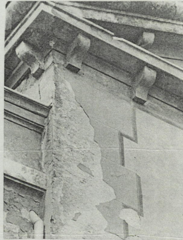
Fig. 37 La Damette - Détail (Photo CERLYAU)
