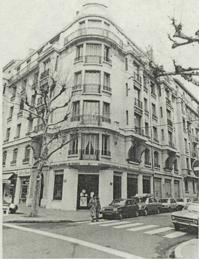
Fig. 63 Etagement avec surplombs et retraits 1930 (11 boulevard des Brotteaux) -
