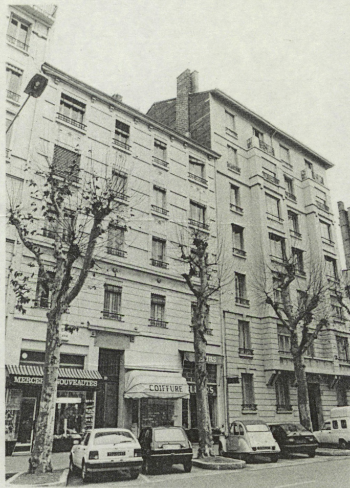
Fig. 47 Immeuble en machefer enduit années 1920 (17 bld des Brotteaux) -
