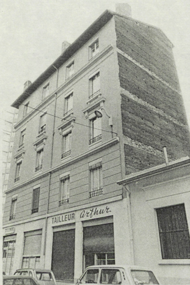
Fig. 32 Immeuble en pisé de mâchefer (début XXème) (angle rues Duguesclin et A. Bonnet) .
