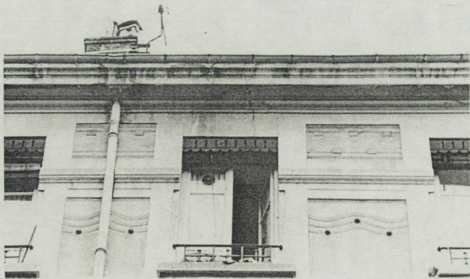
Fig. 40 Interprétation XXème de l'entablement en enduit (immeuble 204, rue de la Guillotière).
