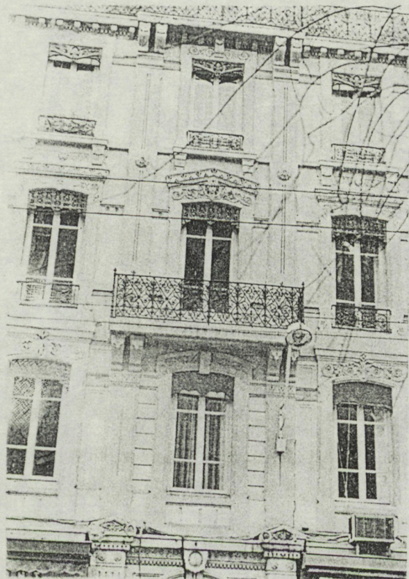
Fig. 1 Détails immeuble (4, rue de la République)
