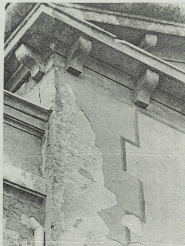
Fig. 37 La Damette - Détail (Photo CERLYAU)
