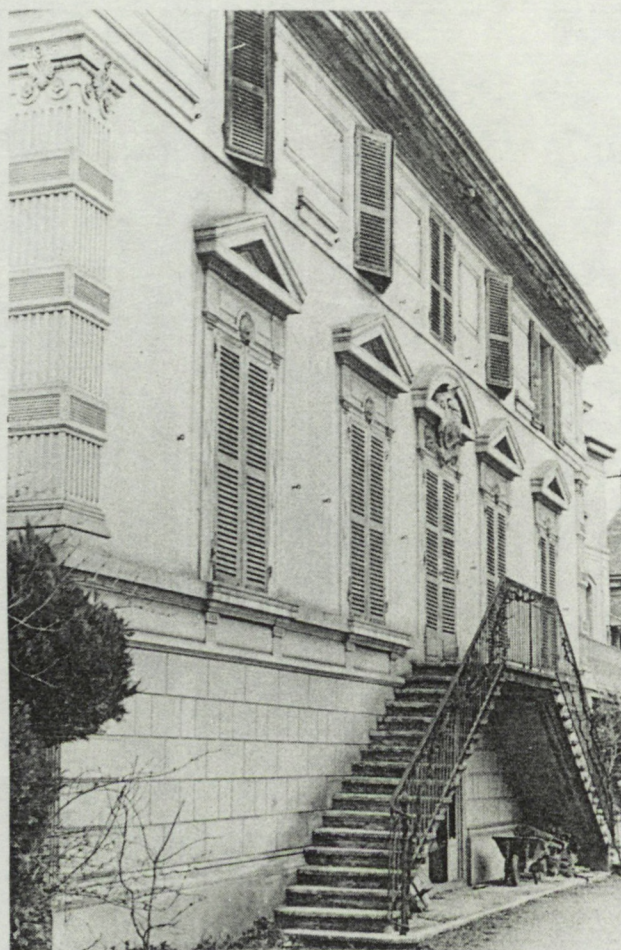
Fig. 85 La corniche de bois : premier indice d'une architecture d'enduit (Maison Relave - Ecully) .
