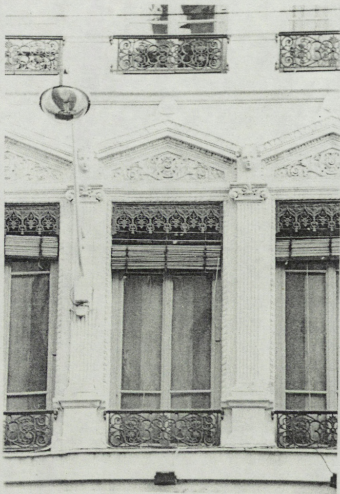
Fig. 56 Fenêtres "en continue" - 1850 (13-15 rue de la République)
