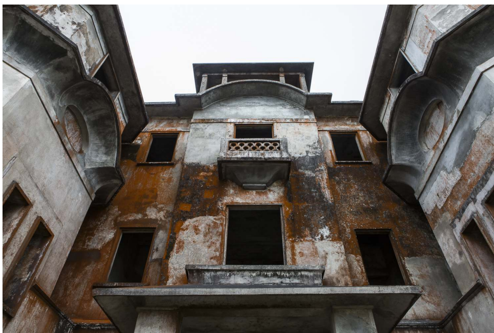
Figure 4 : Détail des vestiges du Bokor Palace en janvier 2017, avant les travaux de rénovation
