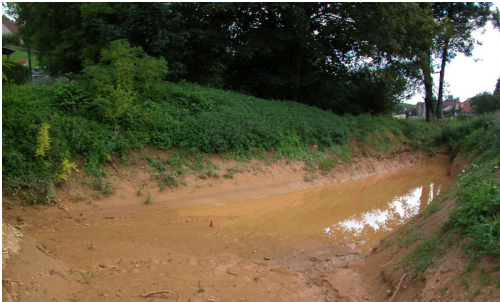
Illus. 4 : Bac de décantation des eaux d'orage et de récupération des terres en bas de versant viticole à Pernand-Vergelesses, analogue à un « terreau » décrit dans les archives anciennes (Photo : Jean-Pierre Garcia, 2007).
