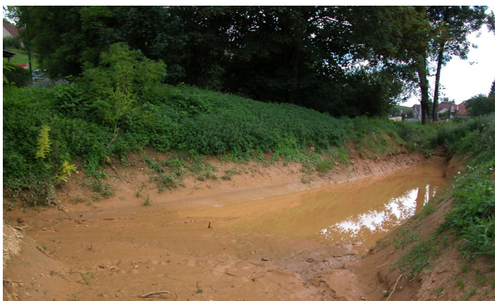
Illus. 4 : Bac de décantation des eaux d'orage et de récupération des terres en bas de versant viticole à Pernand-Vergelesses, analogue à un « terreau » décrit dans les archives anciennes (Photo : Jean-Pierre Garcia, 2007).
