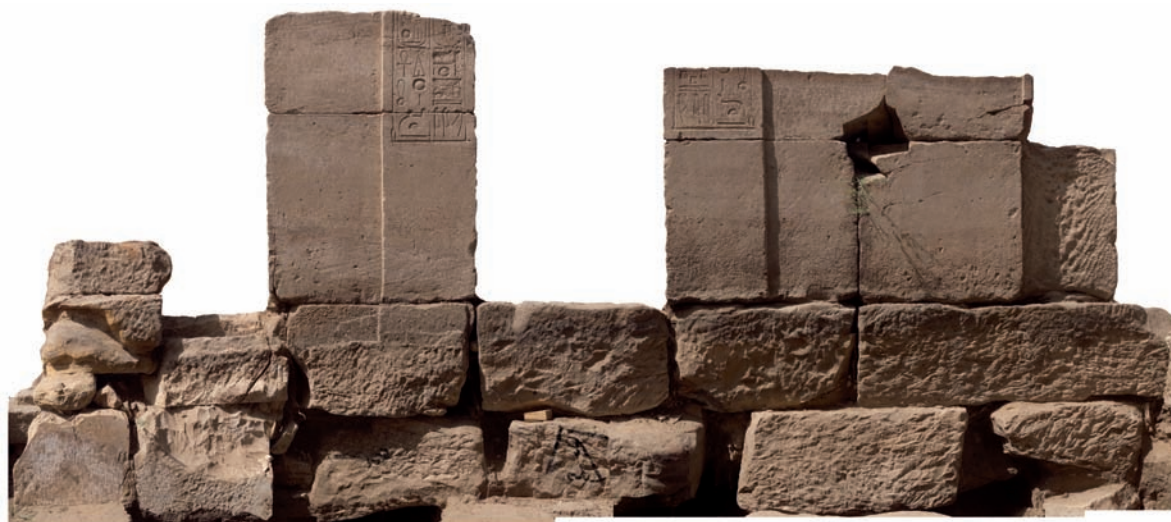
Fig. 16. Emplacement des marques dans le déambuloire sud (ZCT Dbs); face nord des fondations de la façade de la chapelle n° 6, sud de Thoutmosis III : dipinti n°s 15, 16 et 17 (couleurs renforcées). © CNRS-CFEETK n° 88725.
