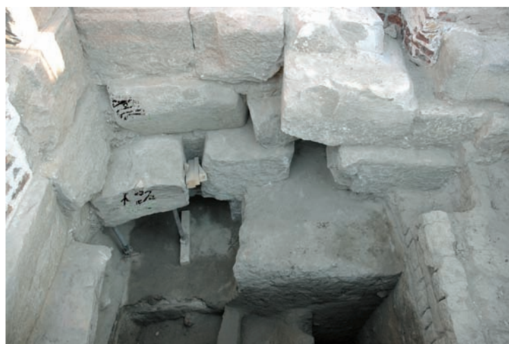
Fig. 22. Emplacement des marques dans les fondations du mur de clôture sud du môle sud du VI e pylône : dipinti n os 20 et 21 (couleurs renforcées). © CNRS-CFEETK.
