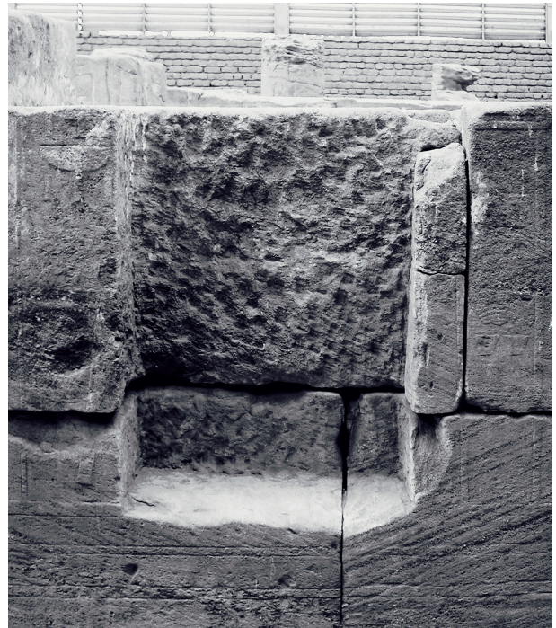
Fig. 7. Temple de Bouhen, logement de plaquette de la paroi extérieure destinée au remplacement d'une figure d'Hatchepsout.
