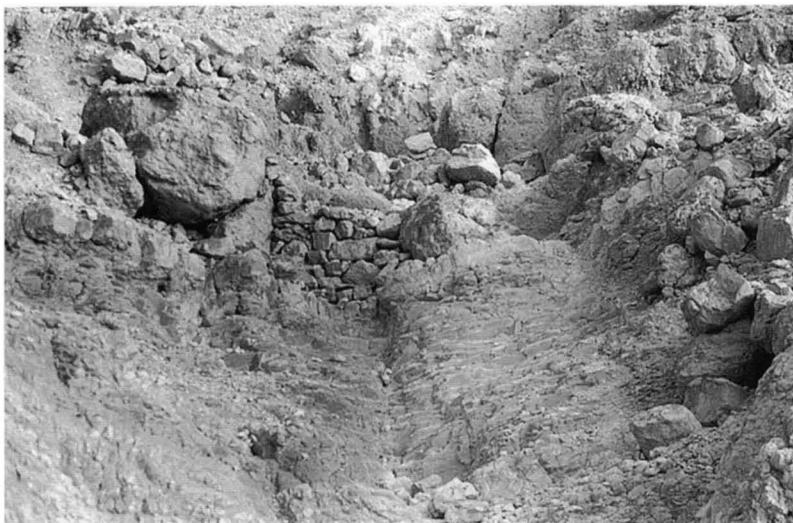
◁ a. Barrage inférieur du ouadi, aménagé devant un réservoir taillé dans le roc.
