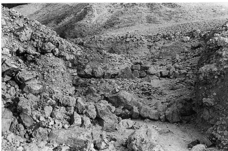
◁ b. Barrage intermédiaire (les deux murs de parement s'aperçoivent sur la gauche du cliché) ; un peu en amont un seuil fait de grosses pierres.
