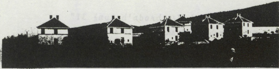
Část kolonie postavené r. 1918. Každý typ obsahuje 1 byt, sestávající z 5 pokojů, kuchyně, lázně a příslušenství. Stavební náklad 90.000 Kč.
