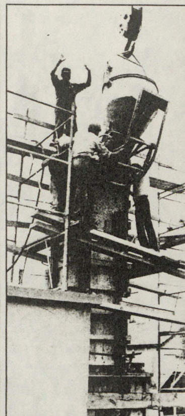
Le béton coulé, à lui seul, demeure plus employé (19 %) que toutes les catégories de préfabriqué réunies (15 %). (Photo P. Granaud)
