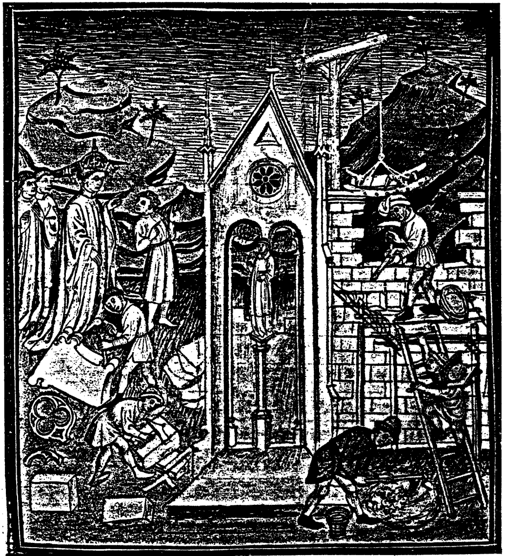
Chantier de construction avec poulies, échafaudages et outils de tailleurs de pierre. (Grandes Chroniques de Saint-Denis, XIVe siècle), tiré de : "Les bâtisseurs de cathédrales", Jean GIMPEL, édition du Seuil 1980
