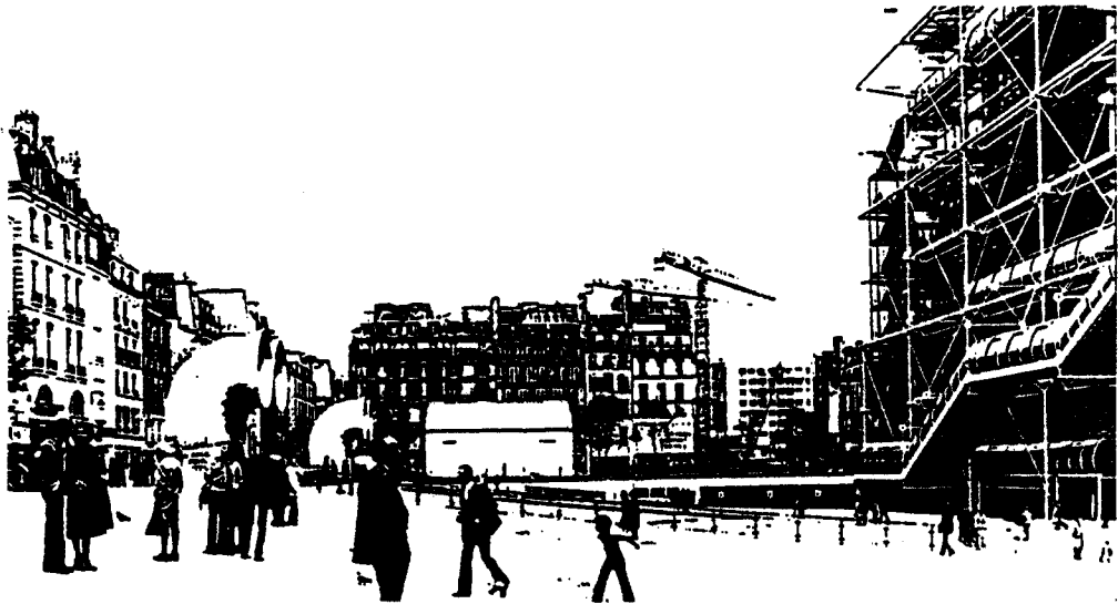
L'ancienne façade (Novembre 1977)
