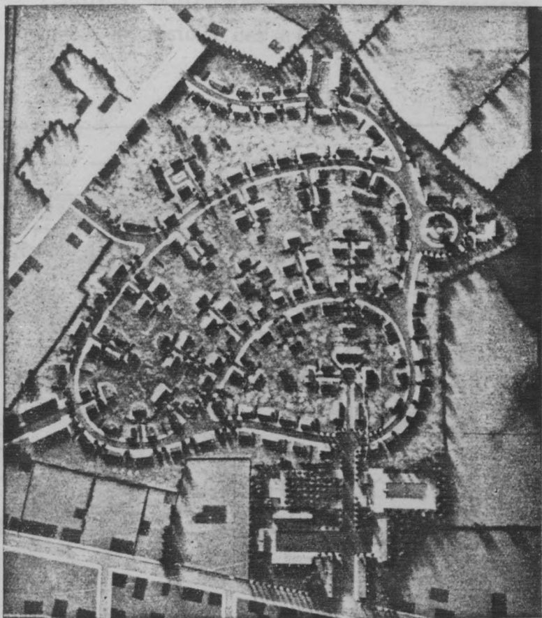
Cité-jardin de maisons provisoires de Sous-le-Bois à Maubeuge, terminée en 1943 par Janin, premier urbaniste de la reconstruction de la ville, et Lafitte, architecte local qui poursuivra sa collaboration avec Lurçat.
