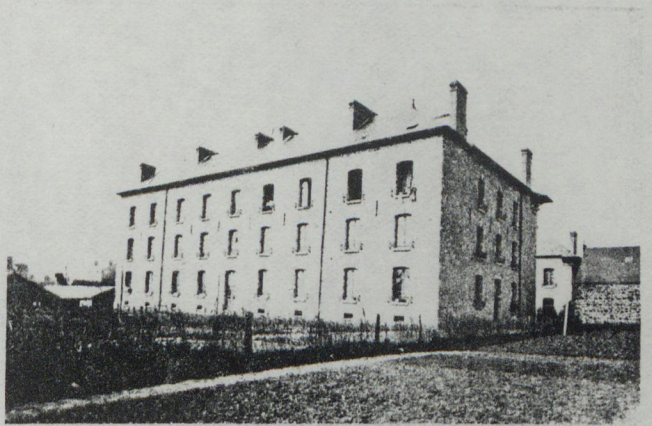
Caserne de FOUGERES Façade arrière
