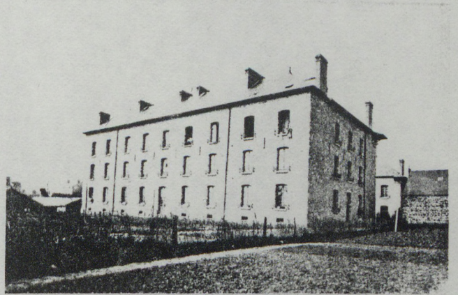
Caserne de FOUGERES Façade arrière
