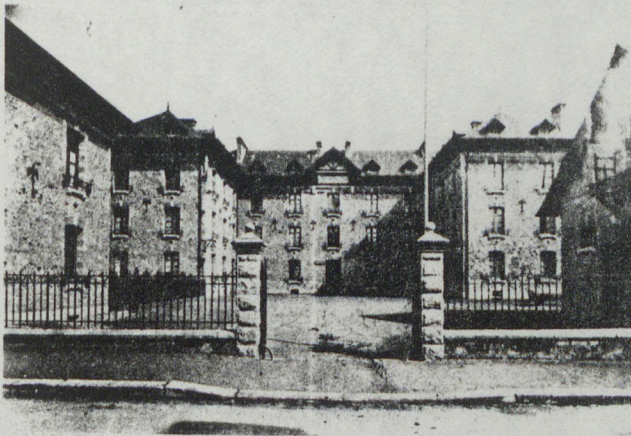
Caserne de FOUGERES Façade principale
