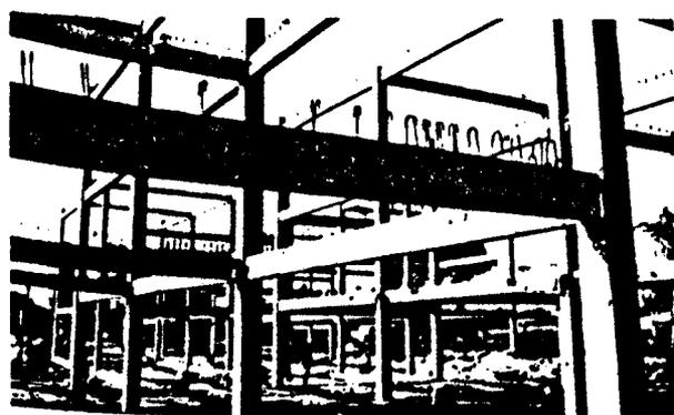
Ossature en béton pour bâtiment (doc. PPS)
