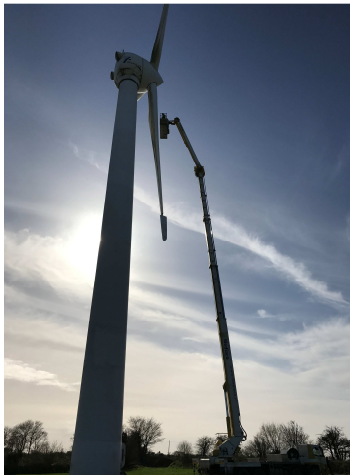
Fig. 5: Eolienne équipée de FBGs.
