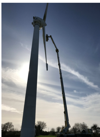
Fig. 5: Eolienne équipée de FBGs.
