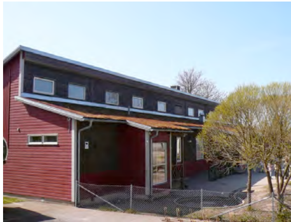
Fig. 18 - Les locaux dédiés au tri des déchets à Augustenborg
