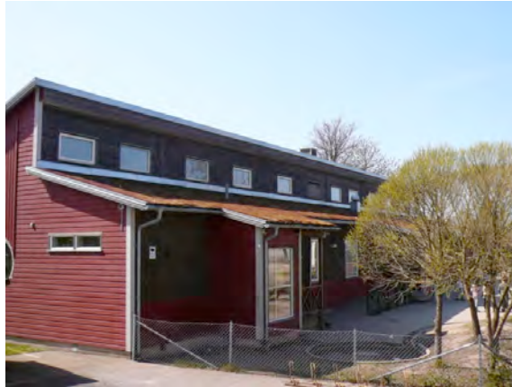
Fig. 18 - Les locaux dédiés au tri des déchets à Augustenborg
