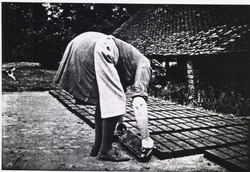
Et on démoule.
