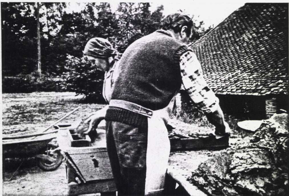
On remplit le moule et on lisse au racloir le dessus. Entre temps l'autre moule est nettoyé et poudré.
