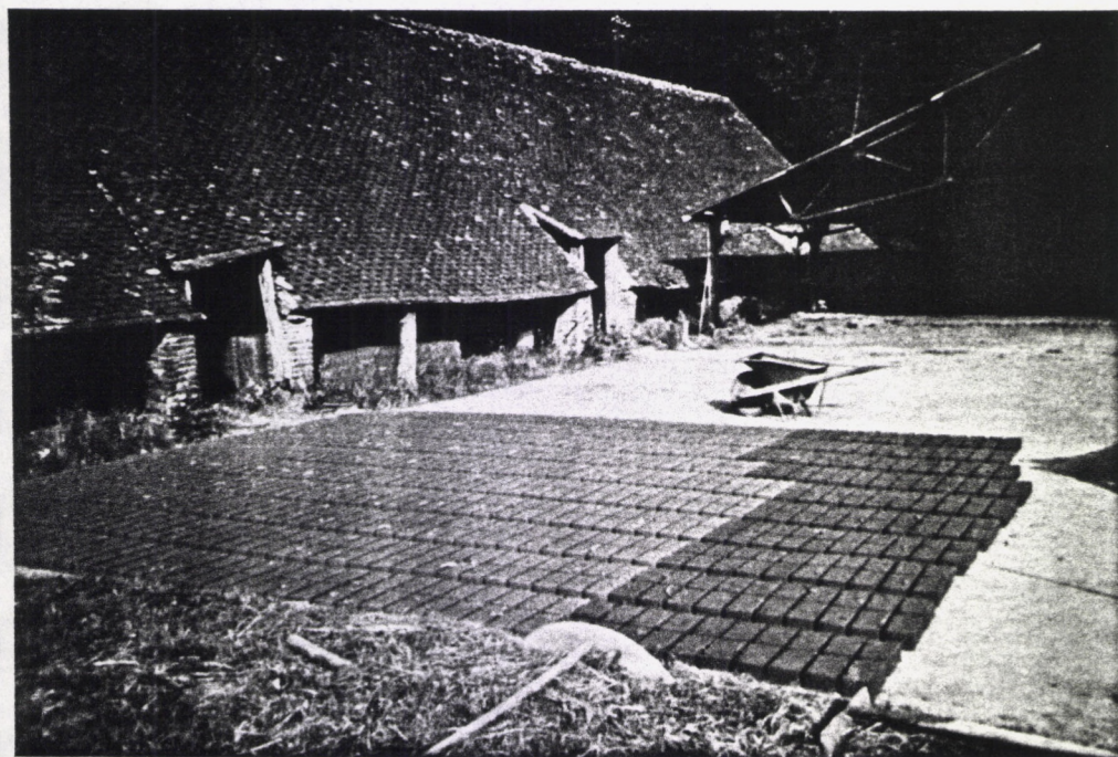
Les briques fraîchement démoulées.
