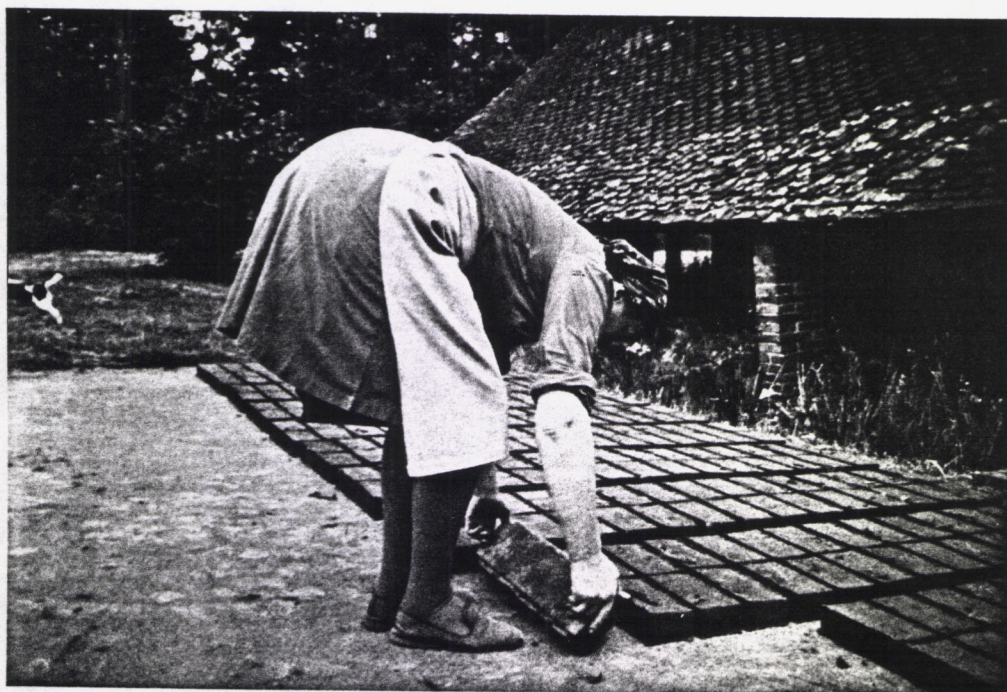
Et on démoule.
