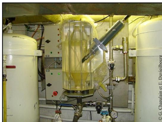
Figure 2. Dispositif SIRANO dans la salle des machines du navire "Enez Eussa III".
