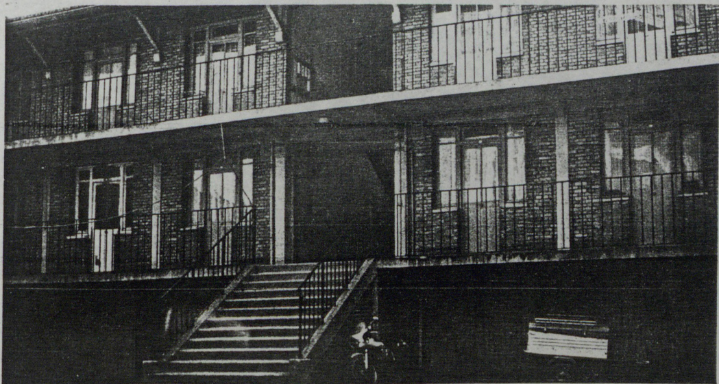
Figure 108 : Logements ouvriers HBM, rue de la Saïda, PARIS.
