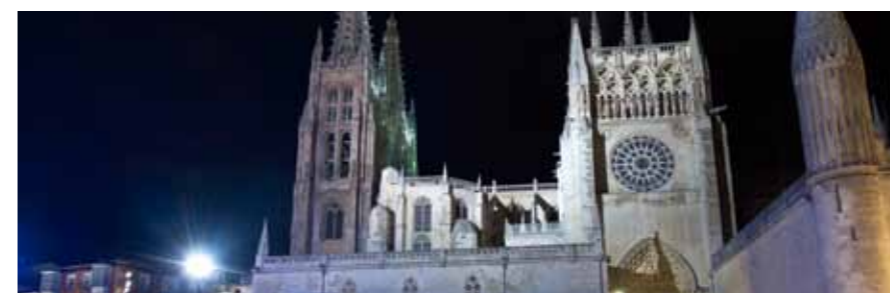
Málaga, Alumbrado decorativo navideño realizado mediante iluminación a base de LED (arriba). Vila Nova de Gaia, iluminación mediante LED en la vía peatonal y carril bici del paseo marítimo (centro). Burgos, iluminación con lámparas de bajo consumo en el entorno de la catedral de Santa María y la Plaza del Rey San Fernando (abajo)
