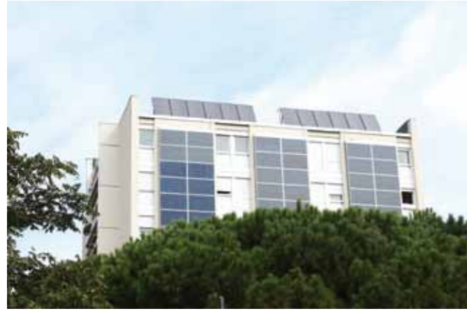
Toulouse, rehabilitación de edificio de viviendas sociales en su aislamiento exterior, e instalación de paneles fotovoltaicos y solares térmicos. Burgos, ARI Río Vena, como ejemplo de rehabilitación energética de edificios (derecha).
