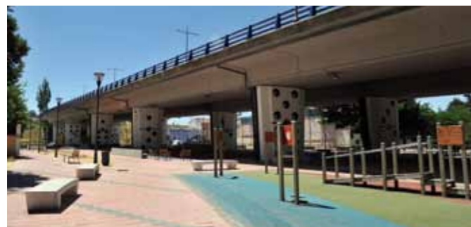
Burgos. Rehabilitación del área correspondiente a los bajos del Puente de la Autovía de Ronda, como espacio público "de bolsillo", Calle Timoteo Arnaiz.
