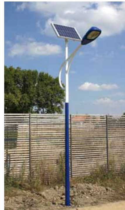
Toulouse, luminaria con panel solar fotovoltaico en el espacio público de Bourderouge.
