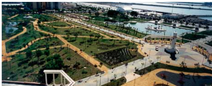
Ejemplo de punto de regulación térmica urbana en Málaga: transformación de los ex depósitos CAMPSA en el Parque Huelin, paseo marítimo del oeste.
