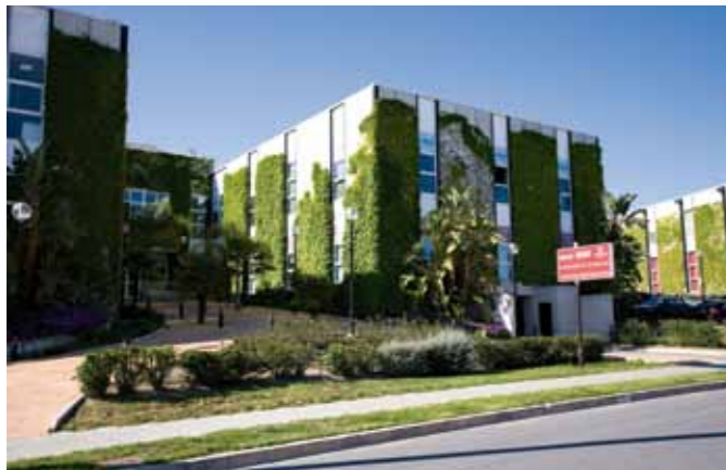
Soluciones de reducción de ganancias y pérdidas térmicas en edificios. Málaga: ejemplo de fachadas verdes en el edificio sede del Instituto Municipal de Formación y Empleo, Parque Tecnológico de Andalucía (izquierda). Toulouse, ejemplo de cubierta verde en un edificio residencial (derecha).
