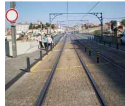
Vila Nova de Gaia. Utilización de materiales autóctonos en la realización de aceras y calzadas de tranvía (Avenida de la República: paralelo y cubo de granito) y en la capilla do Senhor da Pedra (piedra)
