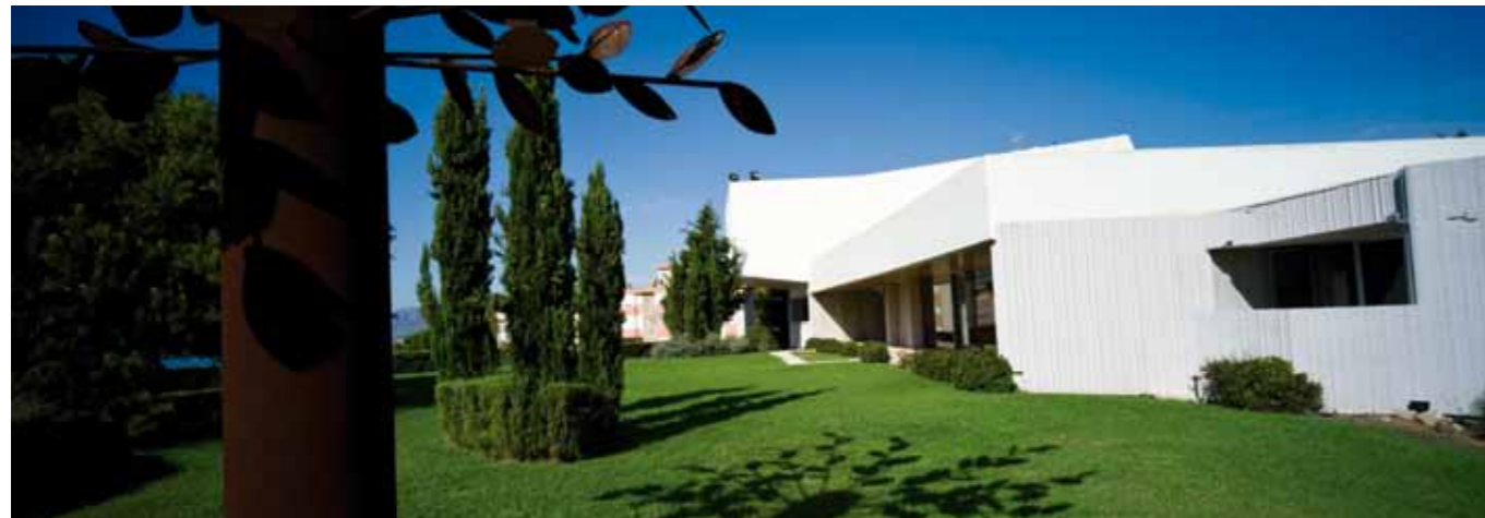
Málaga, Observatorio de Medio Ambiente Urbano. Edificio realizado con técnicas de construcción ecológicas (materiales y vegetación autóctonos, sistema de reutilización de aguas pluviales, orientación norte-sur, paneles solares fotovoltaicos, ...) para minimizar el impacto medioambiental.
