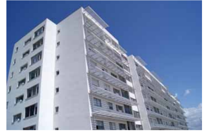
Vila Nova de Gaia, Vila D'Este, rehabilitación de edificios de viviendas sociales, interviniendo en el envoltorio exterior en el aislamiento térmico y los acristalamientos.
