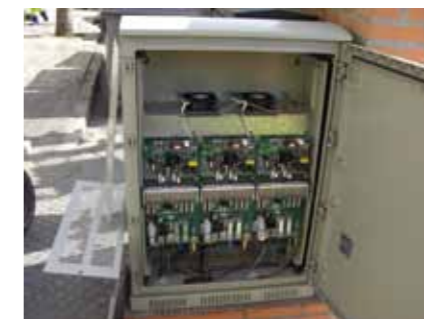
Málaga, alumbrado público en el paseo marítimo dotado de sistema de telegestión y de estabilizadores-reductores de flujo luminoso.
