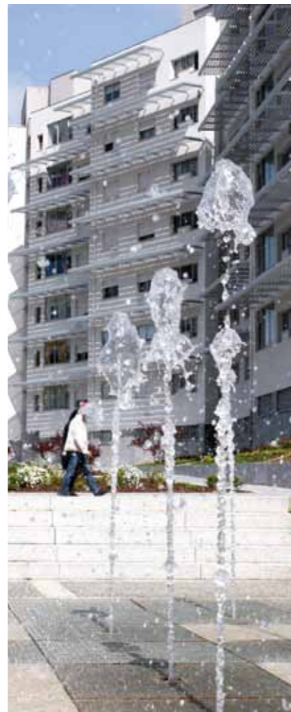
Vila Nova de Gaia, los edificios tienen necesidades energéticas compatibles con la geotermia
