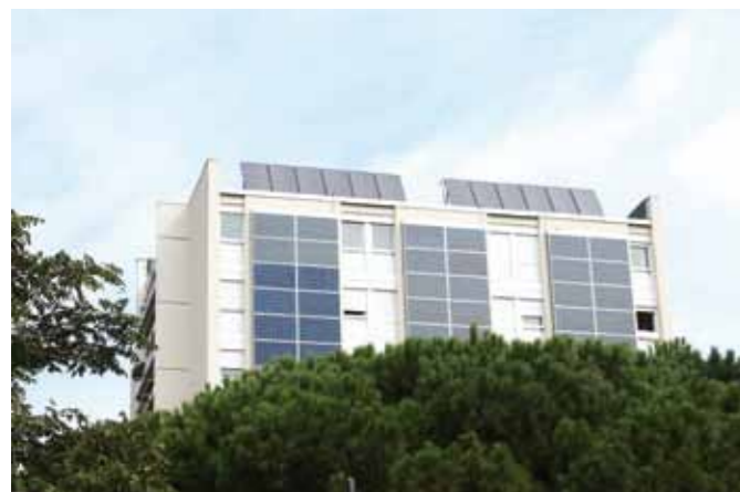
Toulouse, rehabilitación de edificio de viviendas sociales en su aislamiento exterior, e instalación de paneles fotovoltaicos y solares térmicos. Burgos, ARI Río Vena, como ejemplo de rehabilitación energética de edificios (derecha).
