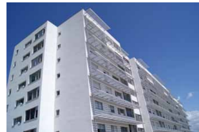
Vila Nova de Gaia, Vila D'Este, rehabilitación de edificios de viviendas sociales, interviniendo en el envoltorio exterior en el aislamiento térmico y los acristalamientos.
