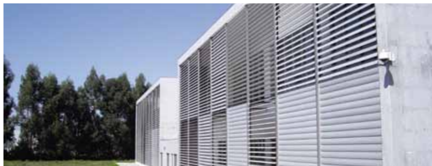
Vila Nova de Gaia, lamas de sombreado en el edificio de viviendas sociales "Vila D'Este" (arriba) y lamas de sombreado regulables en el edificio de servicios "InovaGaia" (abajo).
