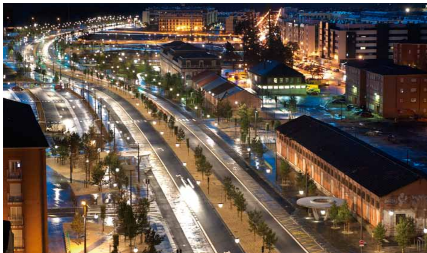
Burgos, bulevar ferroviario, que cuenta con iluminación regulada a doble nivel
