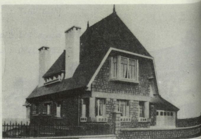
Maison à ST-BRIEUC Arch. : FAUNY (ST-BRIEUC) in l'Ardoise n° 67 - 1942 - P. 7
