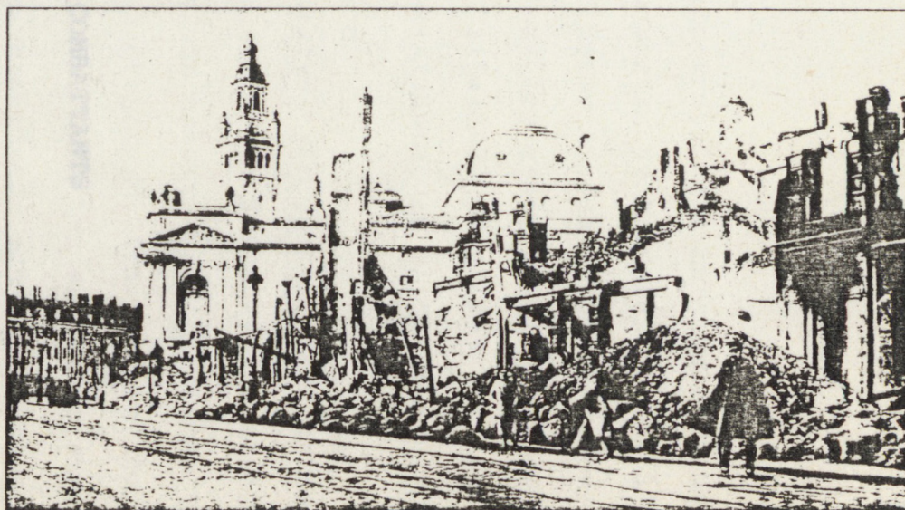
LE THÉÂTRE QUI A ÉTÉ ÉPARGNÉ. DERRIÈRE, ON APERÇOIT UNE TOUR INTACTE QUI EST CELLE DE LA BOURSE
