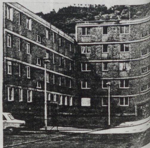
Immeuble K : façade sur séjours identique mais avec jeu de hauteurs ; suppression des séchoirs sur façade d'entrée ; l'aplatissement qui en résulte est compensé par la saillie des porches et de l'"équipement intégré", et par le retour d'angle (bâtiment Q).
