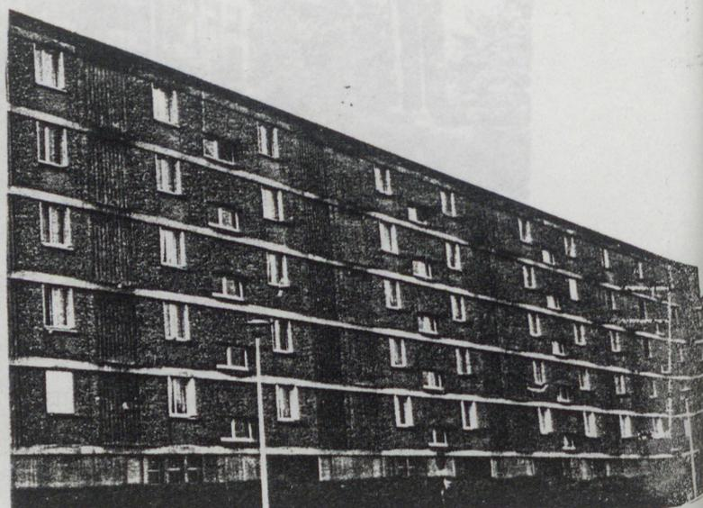
Immeubles A, B, C : suppression des F1 bis provoquant l'uniformisation des fenêtres; sur l'autre façade, suppression des loggias-séchoirs de cuisine pour un séchoir simple, latéral à la cuisine ; suppression des halls traversants.
