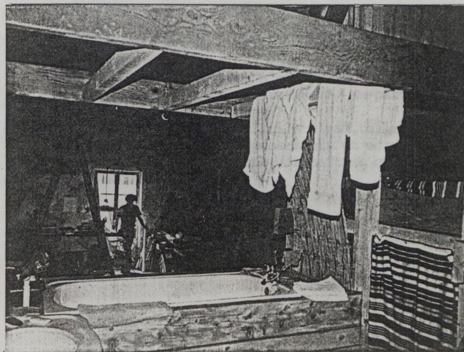
Une seule intervention, homogène (un système poteaux-poutres et planchers bois) permet une partition du volume d'accueil en même temps que l'intégration (système de coffres et de placards) de l'ensemble de l'appareillage technique et de rangement du logis. C'est ainsi que se définit la cuisine - lavage et cuisson sont réduits à un espace minimum et intégrés dans un placard - le plan de travail étant constitué par une table/repas.
